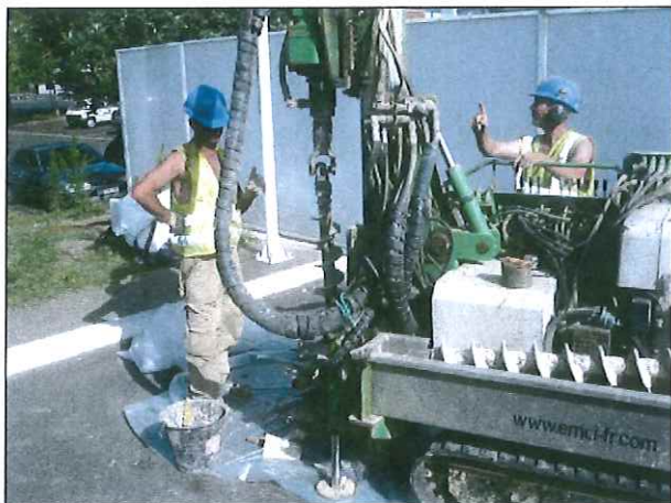
Sondage S14 au Nord-Ouest de l'ancien réservoir retiré de 10m 3 GO
