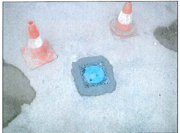
Protection du piézomètre Pz1 par la mise en place de bouche à clé étanche
