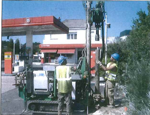
Sondage S6/Pz2 à l'Est du dépotage et au Nord du réservoir multi- compartimentés (7) de 80 m 3
