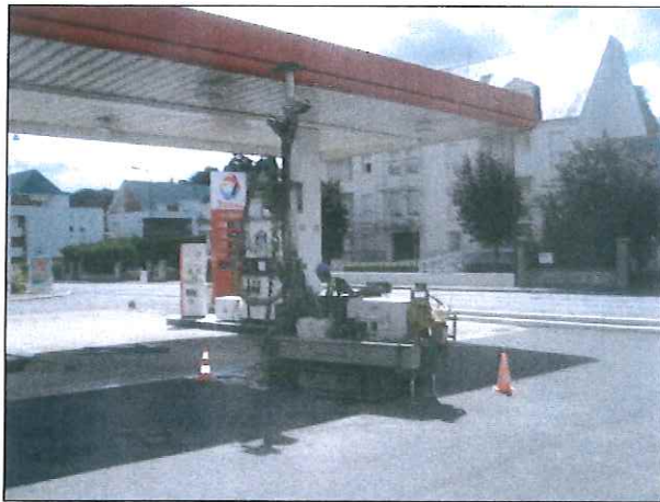
Sondage S8 à proximité des volucompteurs VL de l'îlot central
