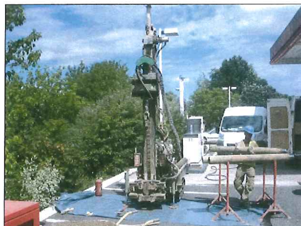
Sondage S3/Pz2 à l'Ouest du dépotage
