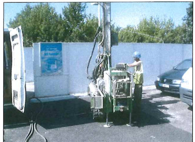
Sondage S15 au Sud de l'aire de lavage
