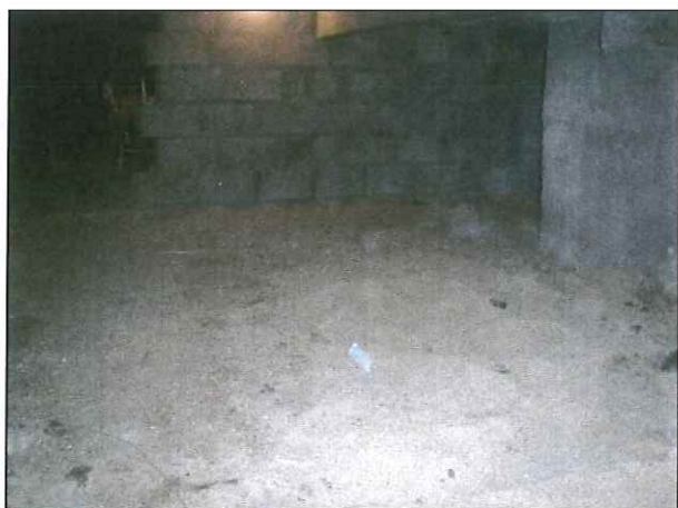
Sondage S2 dans la cave au droit du réservoir retiré de 1,5 m 3 HU
