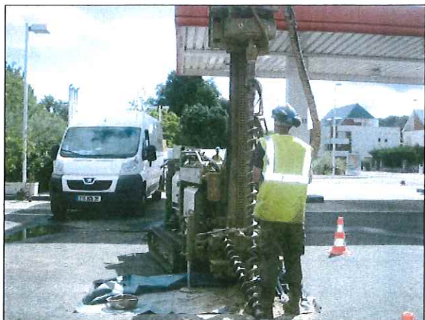
Sondage S4 au Nord-Est du réservoir de 7,5 m 3 HU
