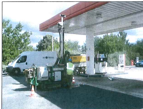
Sondage S5 au Sud de l'ancien réservoir de 15 m 3 de CA et à proximité des volucompteurs de l'îlot central
