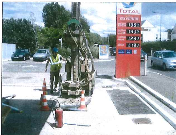
Sondage S10 entre les volucompteurs Sud et le séparateur à hydrocarbures
