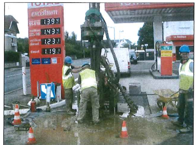
Sondage S11/Pz1 à l'entrée Sud-Est de la station-service
