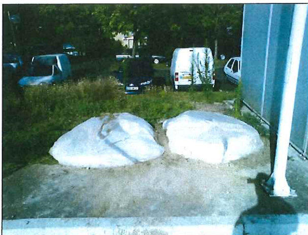
Stockage en Big-bags des matériaux extraits impactés à l'Est de la station-service
